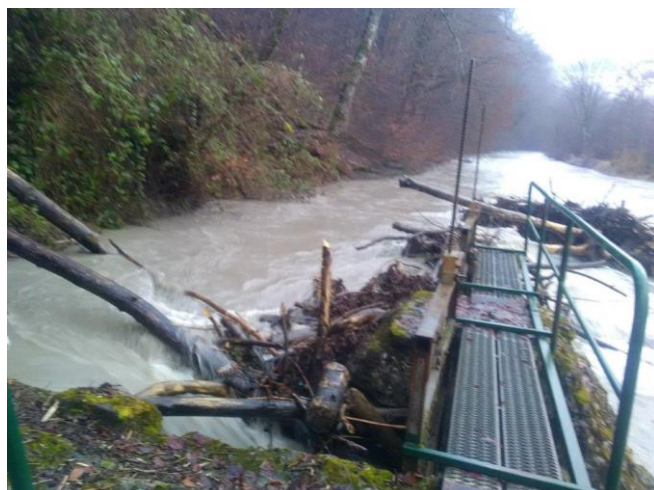
Embâcles sur la prise d'eau du canal Lallier sur la Chaise
