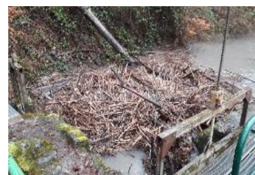
Embâcle sur la prise d'eau du Canal Lallier
