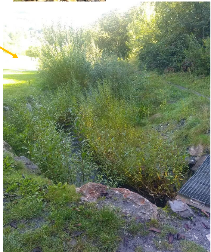
Septembre 2021 - 5 mois après les travaux – bonne reprise des boutures et des fascines
