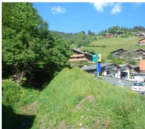
Digue du torrent des Carroz - Beaufort
