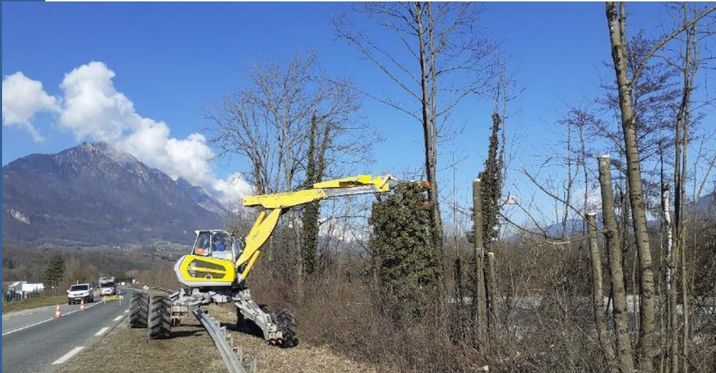
Entretien de la végétation sur la digue de l'Isère à Tournon - Février 2021
