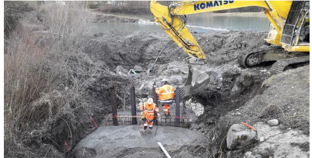
Réfection du piège à embâcle sur le ruisseau de Verrens - Février 2021
