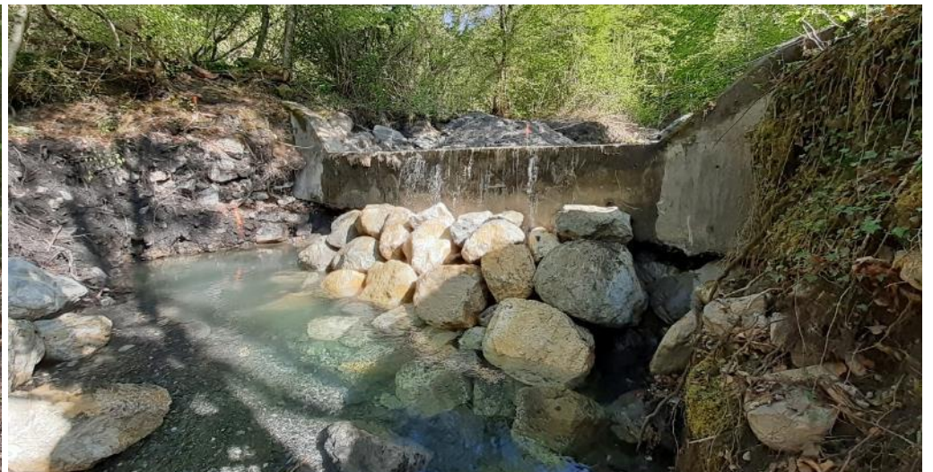
Reprise en sous œuvre du seuil du Moratier - Torrent du Fournieux - Avril 2021
