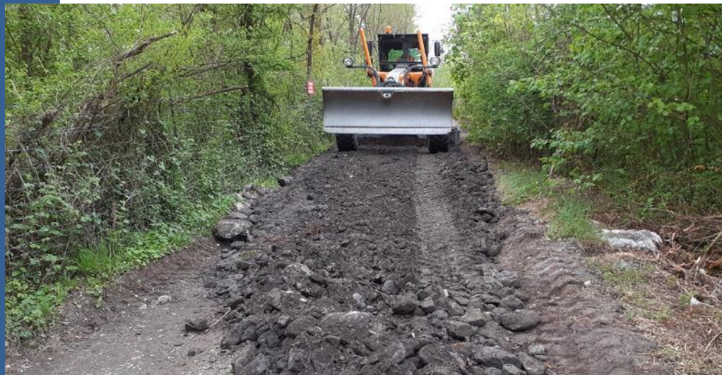
Réfection du chemin de digue - Avril 2021
