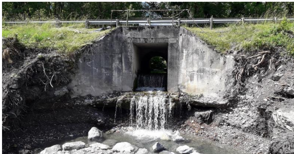
Reprise en sous œuvre de l'ouvrage traversant du ruisseau de la Combe – juin 2021
