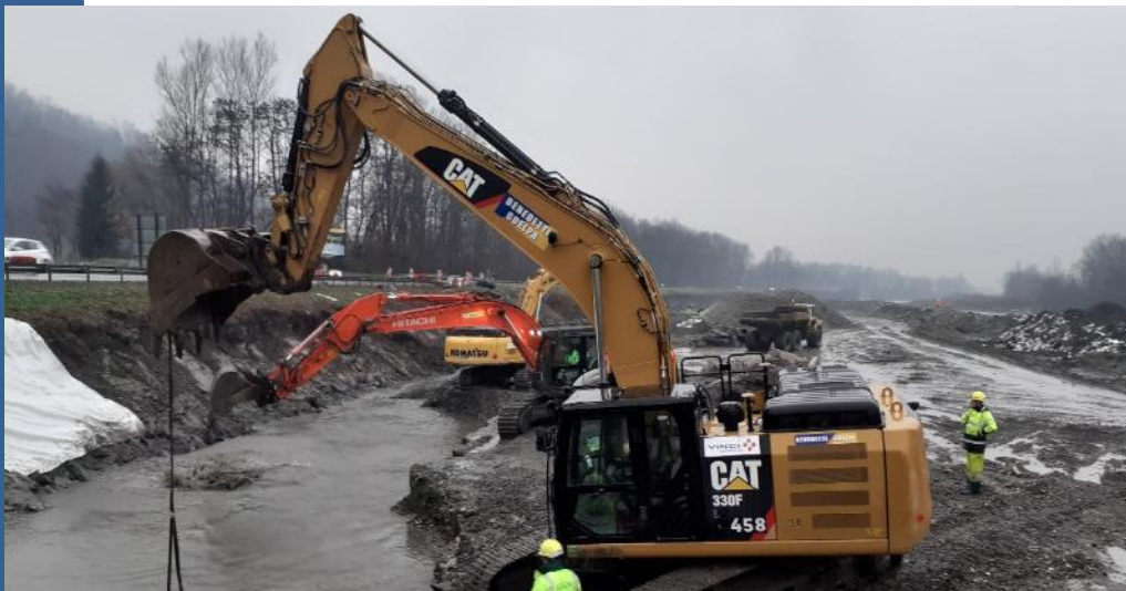
Chantier sécurisation digue Montailleir – 1 er Décembre 2021
