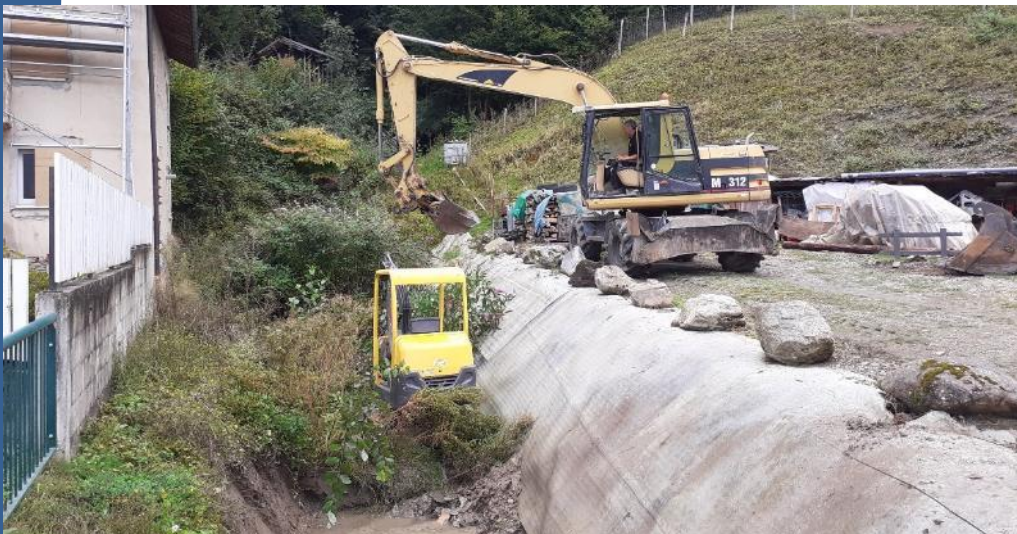
Entretien du ruisseau du Curtet – Villard Lèger – septembre 2021
