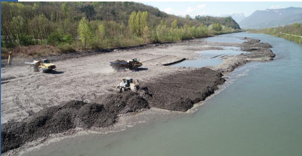
Travaux mécaniques de pérennisation – Avril 2021
